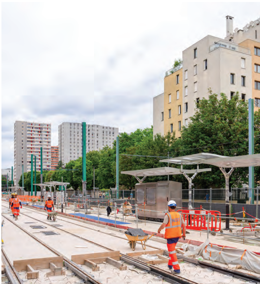
↑ Chantier de la nouvelle station Bobigny - Pablo Picasso sur le T1.
