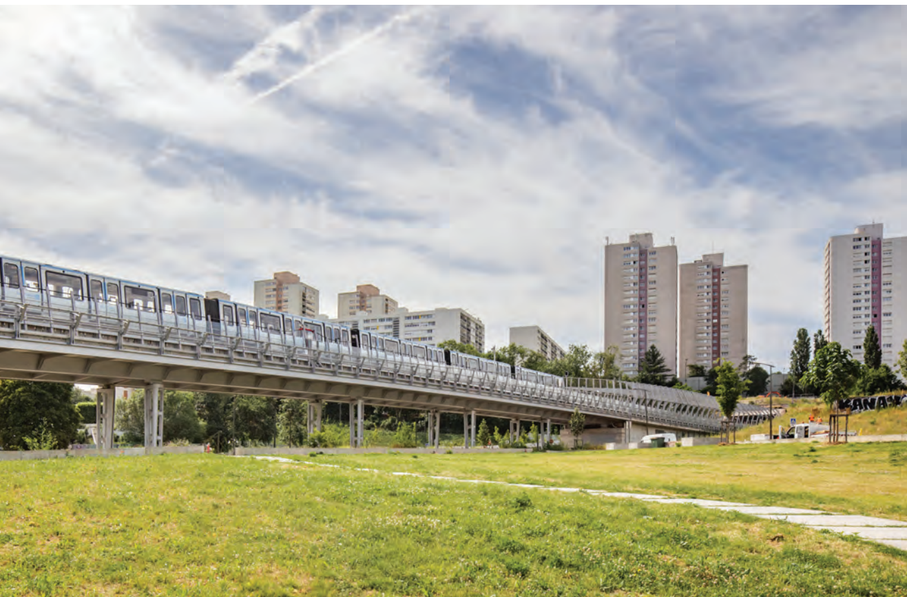
↑ Rame MP14 sur le viaduc de la station Coteaux Beaclair, ligne 11, Rosny-sous-Bois.
